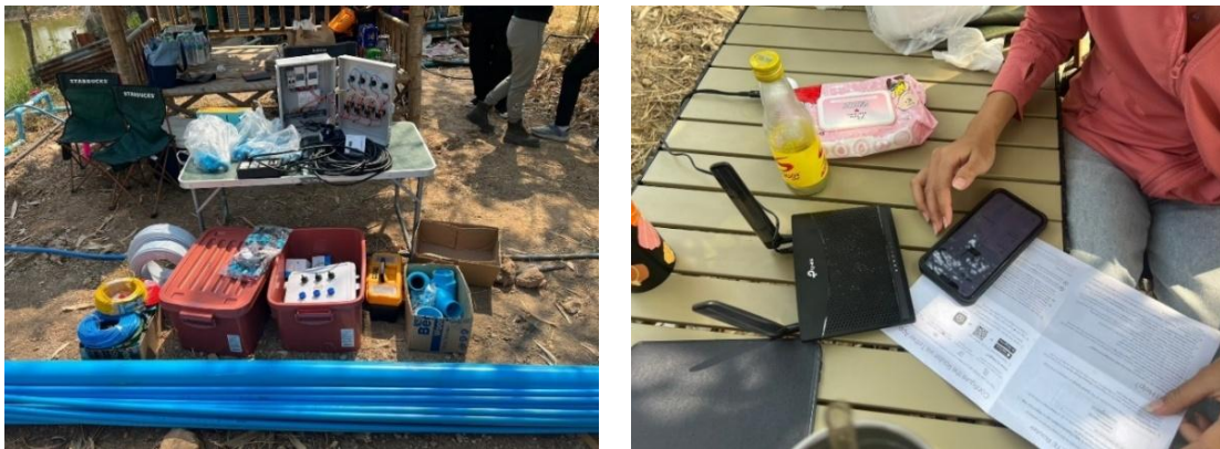
รูปที่ 4 ติดตั้งระบบประปาในพื้นที่แปลงเกษตร และติดตั้งระบบไฟฟ้าและเครือข่ายอินเทอร์เน็ตในพื้นที่แปลงเกษตร
