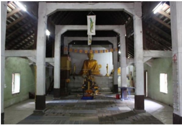
ภาพที่ 8 การเสริมคามคอนกรีตวิหารวัดวังหลวง อ.บ้านโฮ้ง จ.ลำพูน ที่มา : ภาพถ่ายโดยผู้เขียน เมื่อ 14 พฤษภาคม 2558
