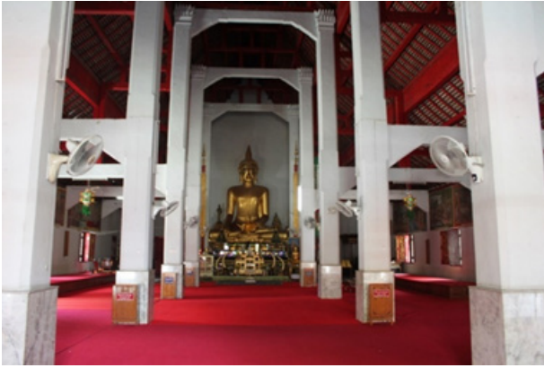
ภาพที่ 7 การเสริมคามคอนกรีตวิหารหลวงวัดพระแก้วดอนเต้าสุชาดาราม อ.เมือง จ.ลำปาง ที่มา : ภาพถ่ายโดยผู้เขียน เมื่อ 13 พฤษภาคม 2558
