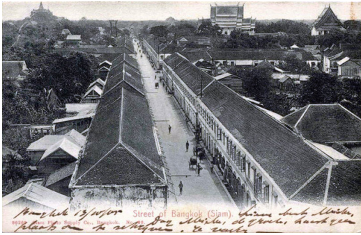
ภาพที่ 7 ตึกแถวถนนบำรุงเมือง
