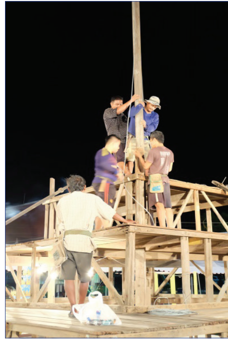
ภาพที่ 6 ทีมงานช่างตั้งเมรุวัดเกาะ ที่มา : ชันญ์ เมฆหมอก. (2560). สำนักและการสืบสานงานช่างไม้ สายสกุลช่างเพชรบุรี. รายงานวิจัยเสนอต่อสำนักงานกองทุน สนับสนุนการวิจัย (สกว.), หน้า 192.
