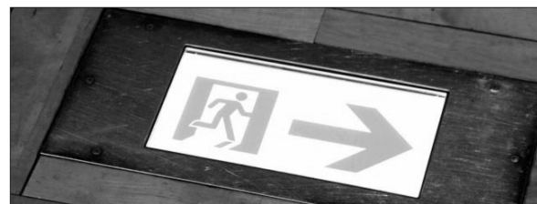
ภาพที่ 18 ป้ายหนีไฟ LED ที่มา : ภาพถ่าย โดย อภิรธรรม สาริบุตร
