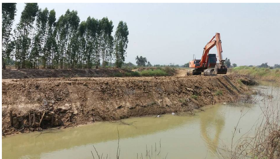
แผนภาพที่ 6 สภาพการขุดลอกคูคลองในพื้นที่ลุ่มน้ำแม่วงศ์
