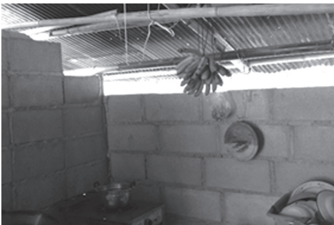
ภาพที่ 3 แสดงลักษณะการเลือกใช้วัสดุก่อนในการก่อสร้าง
