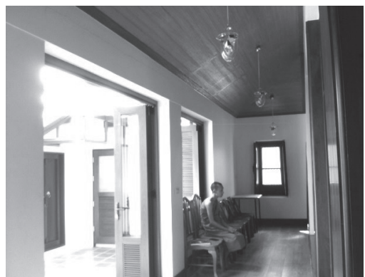
ภาพที่ 17 ภาพทางเดินและประตูหลังการบูรณะ
