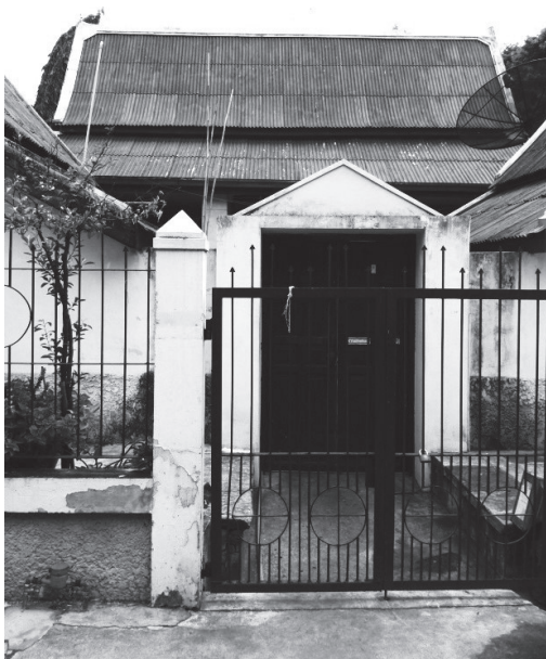
ภาพที่ 20 ภาพซุ้มประตูทางเข้าและกำแพงรั้ว ก่อนการบูรณะ
