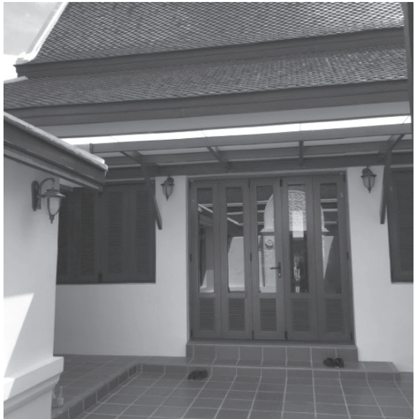
ภาพที่ 5 การใช้วัสดุที่เลียนแบบหรือทดแทนของเดิม เช่น ประตูอลูมิเนียมลายไม้ เจึงชายไม้ สังเคราะห์ ภูมิปัญญา วัดประยูรวงศาวาสวรวิหาร
