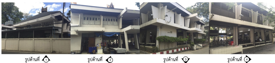
ภาพที่ 3 ลักษณะสภาพตัวอาคารภายนอก
