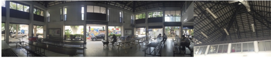
ภาพที่ 4 ลักษณะสภาพภายในอาคารพื้นที่รับประทานอาหารและผ้าเพดานชั้น 1
