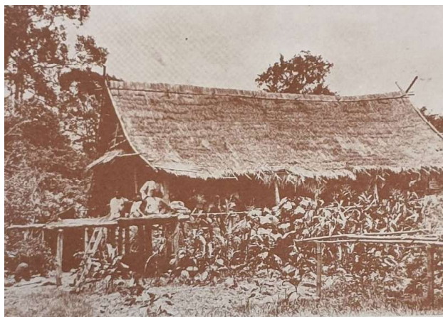
ภาพที่ 10 ลักษณะเรือนเครื่องผูกและหลังคาที่มีการแอ่นตัว เนื่องจากธรรมชาติของวัสดุและรูปแบบโครงสร้าง ที่มา: Nildesh (2019)
