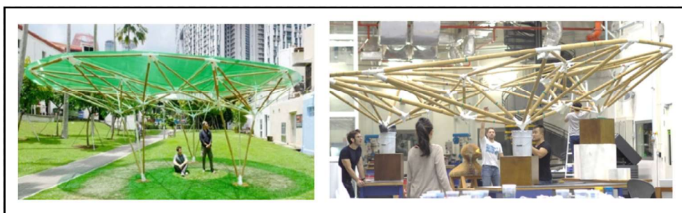
ภาพที่ 8 การประกอบชิ้นส่วนของโครงการ Sombra Verde ประเทศสิงคโปร์ ที่มา: Bañón & Raspall (2020)
