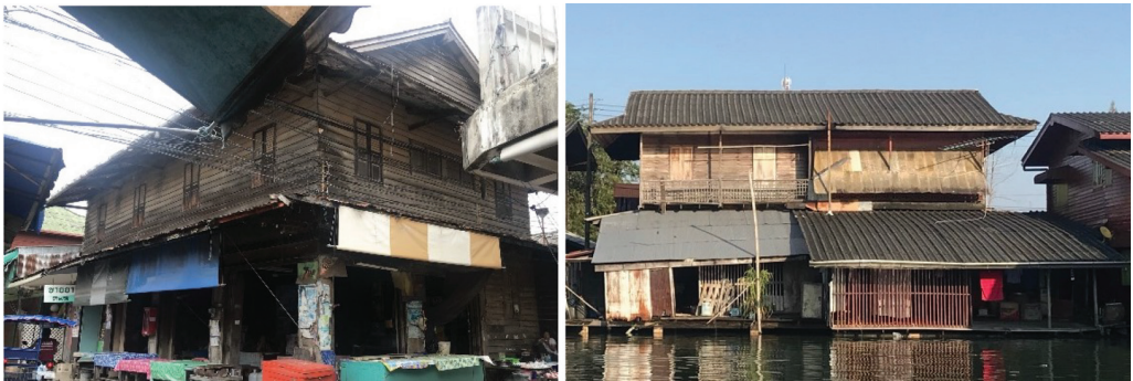
ภาพที่ 6 ลักษณะทางสถาปัตยกรรมของเรือนแถวที่มีคุณค่าอายุระหว่าง 80 – 100 ปี
