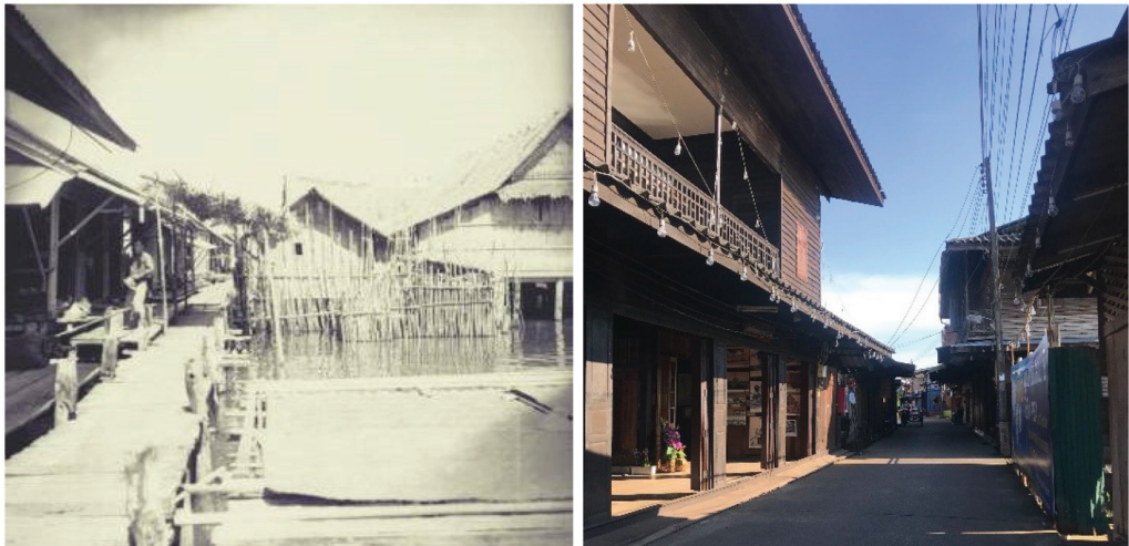
ภาพที่ 3 (ภาพซ้าย) แสดงภูมิทัศน์ของเรือนแถวริมน้ำประแส พ.ศ. 2479 มีทางเดินในลักษณะสะพานไม้ (ภาพขวา) ภูมิทัศน์เรือนแถวไม้ พ.ศ. 2561 ซึ่งจะเห็นได้ว่าถูกเปลี่ยนแปลงเป็นพื้นถนนคอนกรีต ที่มา : Pendleton (1936)
