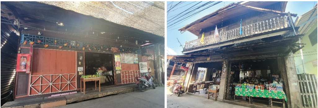
ภาพที่ 7 ลักษณะทางสถาปัตยกรรมของเรือนแถวที่มีคุณค่าอายุระหว่าง 60 – 80 ปี
