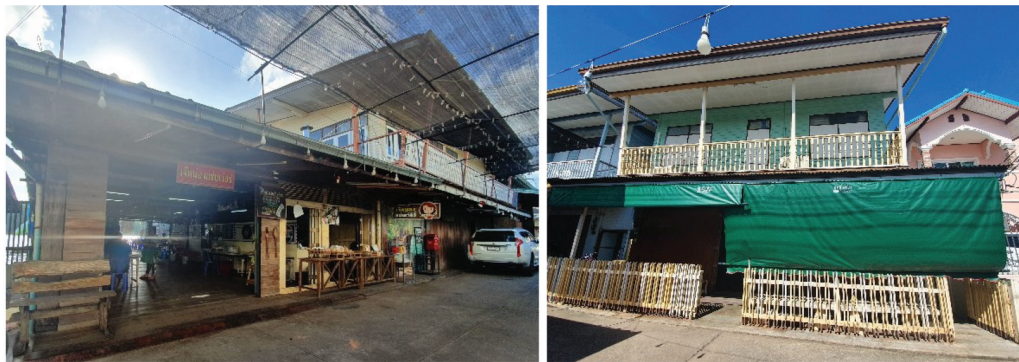
ภาพที่ 8 ลักษณะทางสถาปัตยกรรมของเรือนแถวที่มีคุณค่าอายุระหว่าง 40 – 60 ปี
