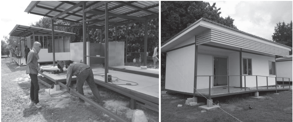
ภาพที่ 6 บ้านอยู่ดีระหว่างก่อสร้าง (ซ้าย) และเมื่อแล้วเสร็จ (ขวา)
