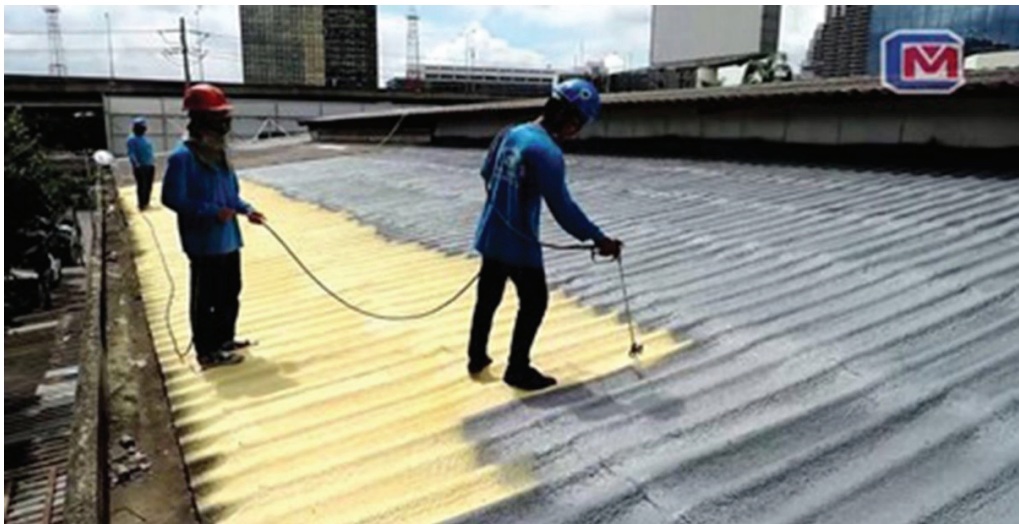
ภาพที่ 5 ตัวอย่างการฉีดพ่นฉนวนโพรพิลีนยูรีเทนบนหลังคา ที่มา: CM coating team (2018)
