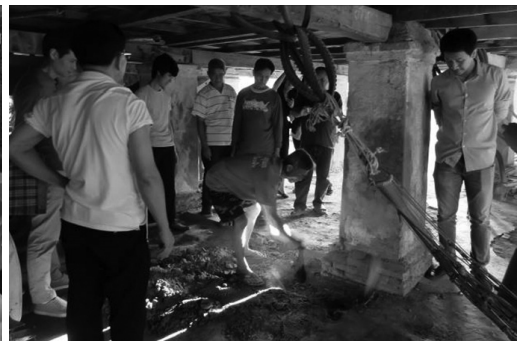
ภาพที่ 14 การขุดดินเพื่อศึกษาระดับพื้นบ้านดั้งเดิม
