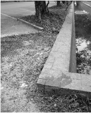
ภาพที่ 5 ขอบคอนกรีตจากการลาดแข็ง คูน้ำที่มีระดับสูงกว่าพื้นดินโดยรอบขัด ขวางการไหลของน้ำผิวดินลงสู่คูน้ำ
