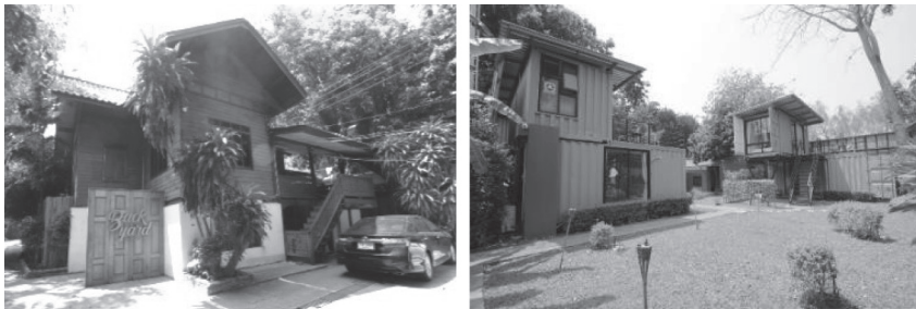
ภาพที่ 5 โครงการร้าน Serene Backyard ที่มีการคงรักษาอาคารบ้านพักอาศัยไม้เอาไวเป็นภาพลักษณ์สำคัญด้านหน้าโครงการ โดยมองเห็นจากถนนเจริญราษฎร์ แล้วสร้างที่พนักท่งที่ยาวด้วยตู้คอนเทนเนอร์ ด้านในโครงการที่ติดริมแม่น้ำปิงแทน
