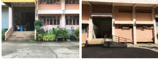
รูปที่ 5 ภาพตัวอย่างทางเข้าอาคารทั้งสองด้านในปัจจุบัน ที่มา : โดยผู้วิจัย
