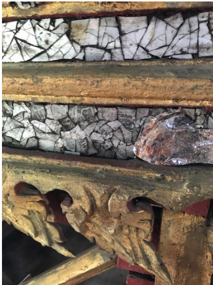
ภาพที่ 9 การเปรียบเทียบกระจกแก้วสีชาว (ทำเก่าเพื่อการบูรณะ) กับกระจกเกรียบที่ผลิตขึ้นใหม่ ด้วยวิธีอย่างโบราณ บริเวณท้องไม้ฐานของธรรมาสน์ยาว วัดเชิงท่า ที่มา : รัชพล เต๋จ๊ะยะยา, 2563, [ภาพถ่าย]
