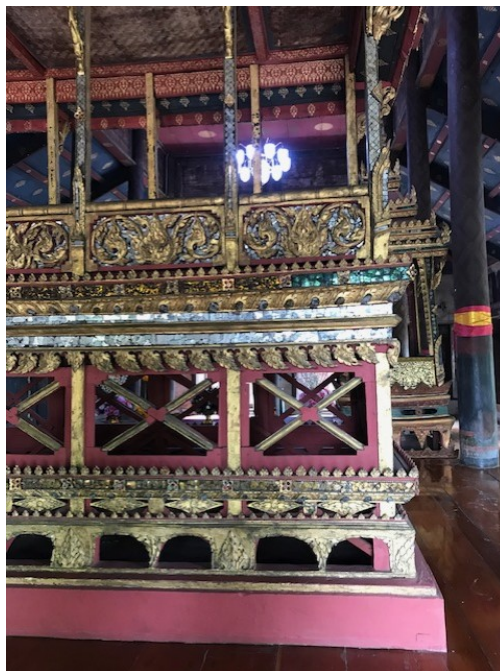
ภาพที่ 1 ส่วนล่างชุดฐานสิงห์ และล่องถุนโปร่งตีเป็นไม้ขัดกันรูปกากบาท ที่มา : รัชพล เต้จ๊ะยา, 2563, [ภาพถ่าย]
