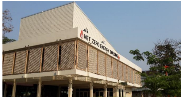
รูปที่ 28 อาคาร Net Zero Energy Building กองสื่อสารองค์กร มหาวิทยาลัยขอนแก่น (Net Zero Energy Building, Communication Affairs Division, Khon Kaen University.)
