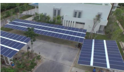
ติดตั้งเป็นหลังคาที่จอดรถ
