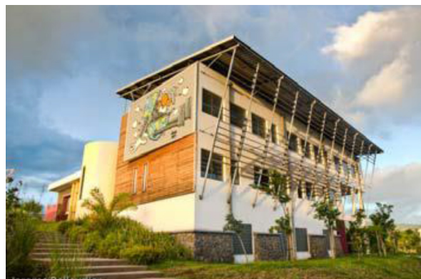
รูปที่ 29 อาคาร Enerpos เกาะ Reunion Island ประเทศฝรั่งเศส (Enerpos, Reunion Island, France.) (IEA Joint SHC Task 40/ECBCS Annex 52, 2014)
