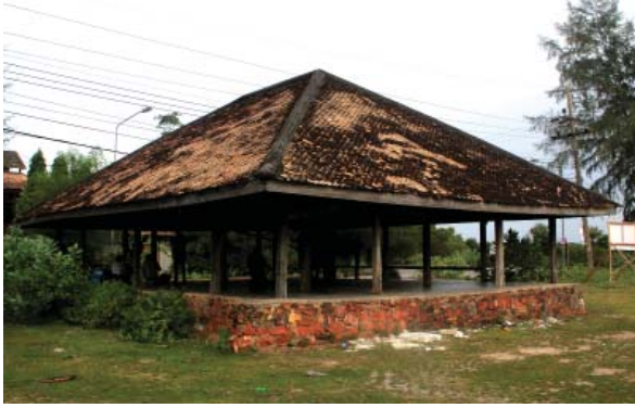
รูปที่ 17 ศาลากลางหน บ้านหาดทรายแก้ว อ.สิงหนคร จ.สงขลา
