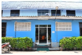
ทางเข้าด้านหลังอาคาร ไม่มีป้ายทางเข้า
