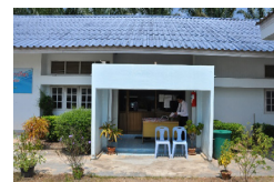
มีสิ่งกีดขวางทางเข้าด้านหน้าอาคารศูนย์ดิจิทัลชุมชน
