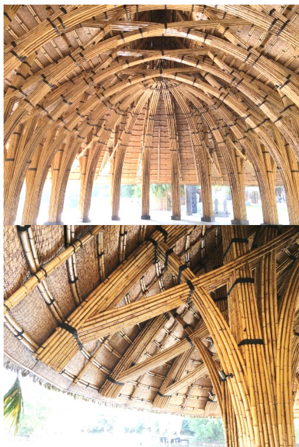
รูปที่ 2 การก่อสร้างโดยมีฐานทางวิศวกรรมหรือการก่อสร้างสมัยใหม่ (Engineered or Modernized Bamboo Construction)
