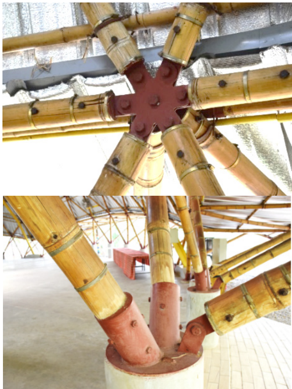
รูปที่ 5 ข้อต่อสถาปัตยกรรมไผ่สมัยใหม่ (Modern bamboo architecture joints)
