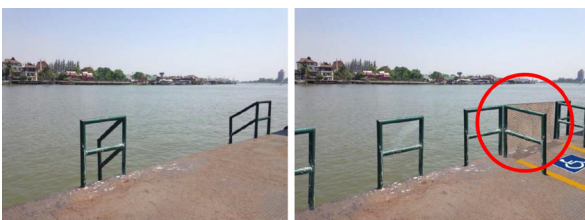
ที่มา: Community for Coexistence and Accessibility in ASEAN: Ko Kret Community Prototype Project, Nonthaburi Province, 2015 รูปที่ 11 การปรับปรุงโป๊ะเทียบเรือท่าเรือปากเกร็ด (The improvement scenario of the pontoon at Pak Kret Pier)
