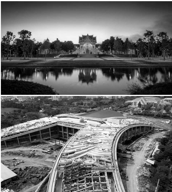
ที่มา: คณะปรับปรุงผังแม่บทมหาวิทยาลัยธรรมศาสตร์ ศูนย์รังสิต, 2559 และ 16 LANDPROCESS, May 4, 2019 รูปที่ 9 ลานหอพระพุทธรูปธรรมทัตศาสดา และการดำเนินการก่อสร้างอาคารปวย 100 ปี ในปัจจุบัน (ปี 2562) (The development of Thidi Sassada Buddha Hall and The current underconstruction of Puay Building 100-year)
