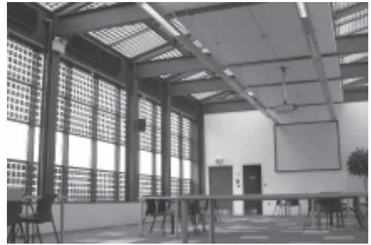
การติดตั้งเซลล์แสงอาทิตย์ทั้งบริเวณผนังกระจกและหลังคากระจก ภายในห้องสัมมนาของอาคาร ZICER [7]
