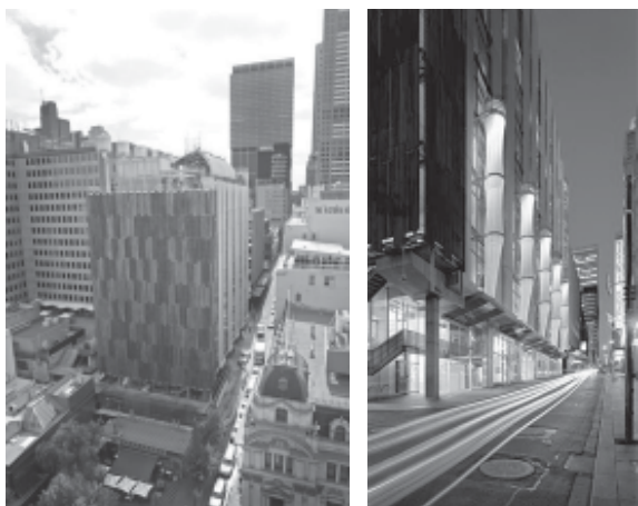
อาคาร CH2 ที่ผู้ออกแบบได้เลือกใช้เทคโนโลยีที่หลากหลายในการช่วยลดผลกระทบต่อสิ่งแวดล้อมทั้งการใช้อุปกรณ์บังแดดที่ปรับมุมได้ [9] และ shower tower ในการลดอุณหภูมิอากาศ [10]
