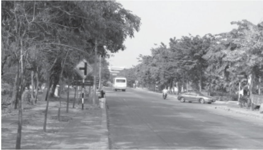
รูปที่ 31 ถนนบริเวณด้านหน้าหอสมุดป๋วย อึ๊งภากรณ์ ซึ่งมีการสัญจรอย่างหนาแน่นในช่วงเวลาเร่งรีบ ไม่มีการแยกช่องทางสัญจรอย่างชัดเจนและไม่มีการทำจุดชะลอความเร็วบริเวณทางแยก จึงก่อให้เกิดอุบัติเหตุบ่อยครั้ง
