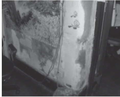
รูปที่ 8 การเกิดเชื้อราที่ผนังอาคารแห่งหนึ่ง
