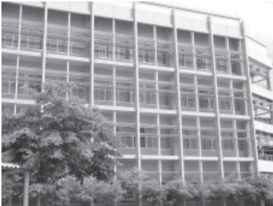
รูปที่ 1 ลักษณะภายนอกของอาคาร
