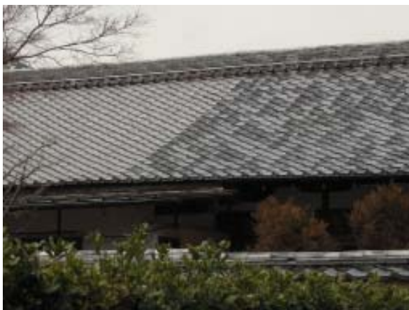
รูปที่ 1 การบูรณะเบื้องหลังคาใหม่ทั้งแถบทางซ้ายมือ
