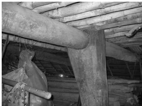
รูปที่ 18 เสาไม้ลักษณะเป็นไม้ง่ามที่เรือนกระตองเต่าดั้งเดิมที่บ้านแม่ประจันต์
