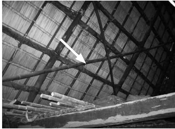
รูปที่ 17 ไม้ไขว้ขาเป็ยที่เรือนกระตองเต่าดั้งเดิมที่บ้านแม่ประจันต์
