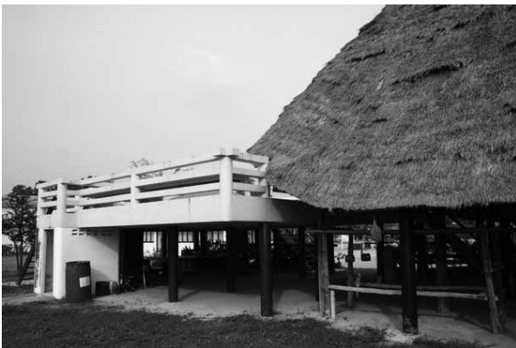
รูปที่ 22 เรือนกระดองเต่าจำลองที่บ้านหนองปรัง มีขานเป็นคอนกรีตเสริมเหล็ก
