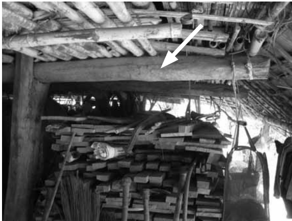
รูปที่ 19 คานหรือรอดยื่นที่เรือนกระดองเต้าดั้งเดิมที่บ้านแม่ประจันต์
