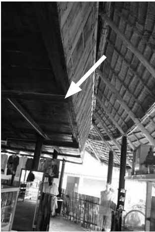
รูปที่ 21 เรือนกระดองเต่าจำลองที่บ้านเขาย้อย (ก) ฝั่งแนวเสา ไม่มีการสอดตัวเข้าที่ก้านและขาน (ข) รอดยึ้นน้อยลง เพิ่มเสารับชายคา
