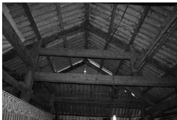
รูปที่ 13 เรือนไทดำแบบมีเสากลางเรือนใช้เสาตึกดาเพื่อลดเสากลางเรือนในบางหลัง จังหวัดเดียนเบียน
