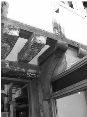
รูปที่ 20 อาคารโครงไม้ที่เมืองออกซฟอร์ด (Oxford) ในประเทศอังกฤษ (ก) มีการยื่นที่ชั้นสองและสาม (ข) ส่วนโครงสร้างพื้นและผนัง
