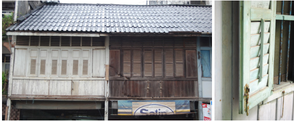
ที่มา: ผู้วิจัย, ห้องแถวเลขที่ 51 (กรณีศึกษาที่ 4) ถ.กันตัง เมืองทับเที่ยง รูปที่ 16 แสดงหน้าต่างบานเกล็ดไม้ปรับมุม (Illustration the window with louvred shutters.)
