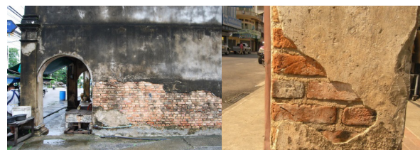
ที่มา: โดยผู้วิจัย, สักราวเมื่อ 11 มีนาคม 2560 รูปที่ 4 ผนังก่ออิฐรับน้ำหนัก ห้องแถวหัวถนน เมืองกันตัง (Load bearing wall of Hua thanon shophouse in Kantang.)
