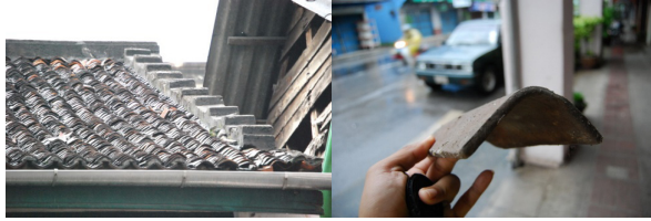
ที่มา: ผู้วิจัย, ห้องแถวเลขที่ 33 (นายชา ช่ายม่าน) ถนนกันตัง เมืองทับเที่ยง รูปที่ 5 รูปทรงหลังคาจั่วที่มีความลาดชันมากและมุงด้วย กระเบื้องดินเผาลอนโค้ง (กระเบื้องจีน) (Pitched roof shape with very slope and covered with U-shaped terracotta roof tiles (may be called “Chinese tile” in Thai.)
