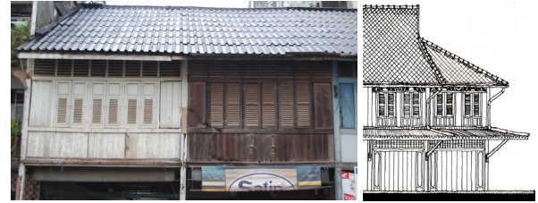
ที่มา: ผู้วิจัย, สํารวจเมื่อ 7 มิถุนายน พ.ศ. 2556 รูปที่ 6 ซ้าย: ประตู-หน้าต่างและช่องลมระบายอากาศที่เปิดตลอดช่วงเสา (Span) เลขที่ 51-53 (กรณีศึกษาที่ 4) ถ.กันตังเมืองทับเที่ยง ขวา: การยื่นชายคา หรือหลังคาที่นําสาดเพื่อให้ร่มเงาและป้องกันละอองฝน เลขที่ 112 (กรณีศึกษาที่ 2) ถ.ราชดำเนิน เมืองทับเที่ยง (Left: Door-window and ventilation block open throughout the span : Case study 4: no 51-53 Kantang rd. Thapthiang. Right: Canopy roof or cantilevered roof to shade and prevent the rain.)
