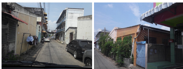
รูปที่ 3 การกลายรูปและสร้างใหม่ของบ้านแถวชั้นเดียว (The transformation and reconstruction of single-floor row house)
