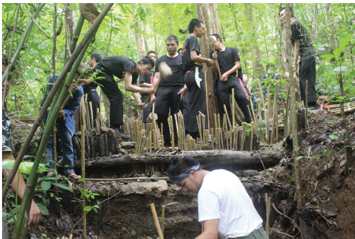
ภาพที่ 11 การซ่อมแซมฝายขนาดเล็กในลำห้วยสาขาบริเวณน้ำตกแม่สา ตำบลแม่แรม อำเภอแมริม จังหวัดเชียงใหม่ เพื่อกักเก็บน้ำและชะลอการไหลเร็วของกระแสน้ำ
