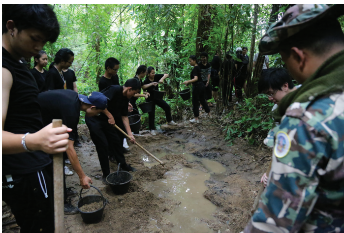
ภาพที่ 12 การขุดลอกดินโคลนบริเวณสันฝายเพื่อนำขึ้นไปทิ้งบริเวณรอบๆ ฝาย หรือเรียกว่า แก้มฝาย
