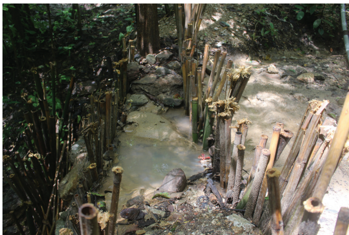
ภาพที่ 13 ฝายหลังจากการซ่อมแซมสามารถกักเก็บและชะลอน้ำไว้ตามแนวลำห้วยสาขา
