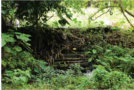
ภาพที่ 3 ฝายไม้เนื้อแข็งวางท่อนไม้แนวขวางลำน้ำและตอกยึดด้วยไม้หลัก
