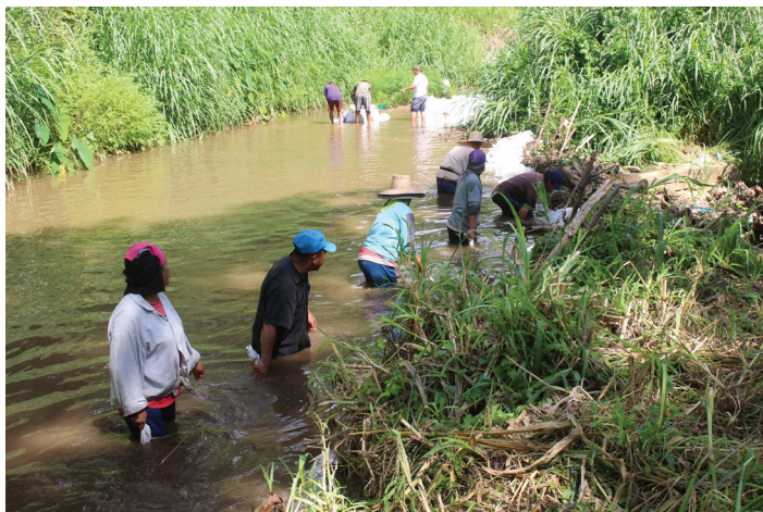
ภาพที่ 9 ชาวบ้านที่ยังคงดำรงอาชีพเกษตรกรรมช่วยกันเรียงกระสอบทรายแทนการตีฝายเพื่อกั้นน้ำไปหล่อเลี้ยงไร่นาในช่วงฤดูการเพาะปลูก
