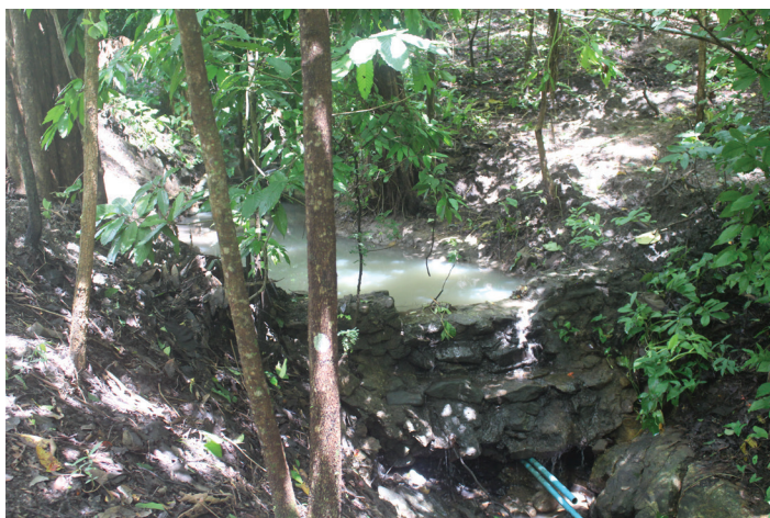
ภาพที่ 14 การกักเก็บน้ำของฝายหินภายหลังการขุดลอกดินโคลน และชะลอน้ำไหลเร็วในลำห้วยที่มีความลาดชัน
