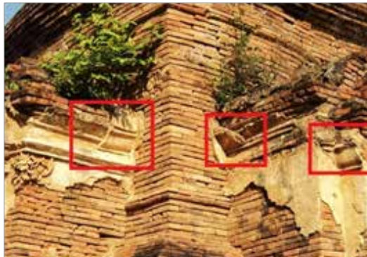
ภาพที่ 3 ร่องรอยการฉาบปูนทับปูนเดิมของเจดีย์ประธาน วัดเกาะกลาง (บันทึกภาพเมื่อ พ.ศ.2555)
