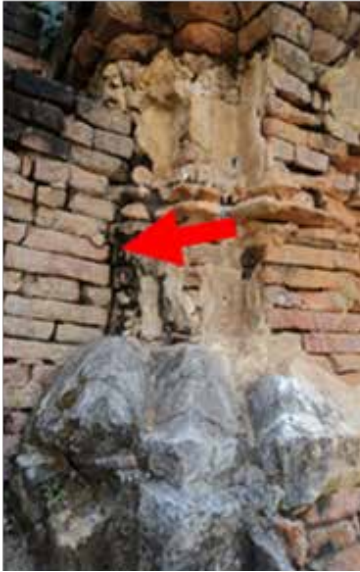
ภาพที่ 4 ร่องรอยการก่ออิฐฐานเชิงที่เพิ่มเข้ามาทั้ง 4 มุมของเจดีย์ประธานวัดเกาะกลาง (บันทึกภาพเมื่อ พ.ศ. 2555)
