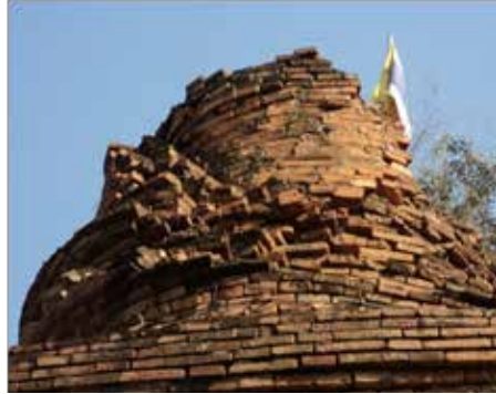
ภาพที่ 2 ร่องรอยการก่ออิฐทับองค์ระฆังของเจดีย์ ประธานวัดเกาะกลาง (บันทึกภาพเมื่อ พ.ศ.2555)
