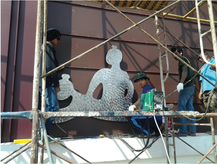
ภาพที่ 22 ภาพเหตุการณ์ระหว่างการก่อสร้างและติดตั้งประติมากรรมขนาดใหญ่โดยผู้วิจัย
