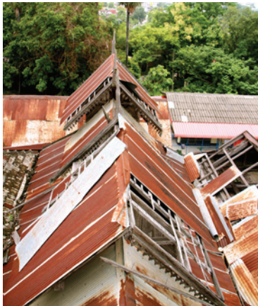
ภาพที่ 14 ความชำรุดทรุดโทรมของหลังคาสังกะสีที่ให้น้ำฝนรั่วเข้าไปได้ในอาคาร
