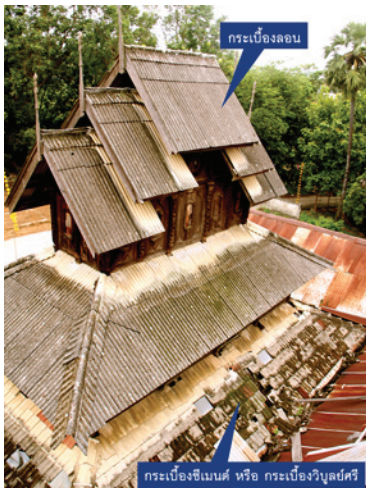
ภาพที่ 14 ความชำรุดทรุดโทรมของหลังคาสังกะสีที่ให้น้ำฝนรั่วเข้าไปได้ในอาคาร
