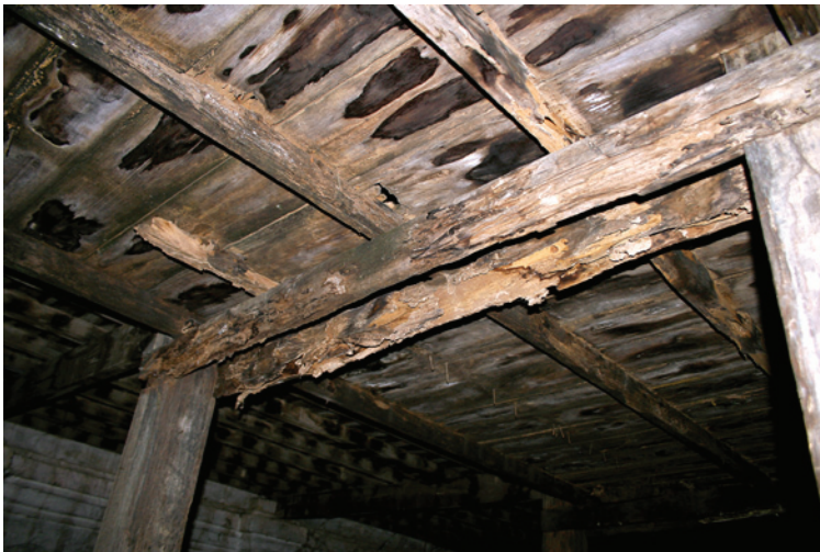
ภาพที่ 11 การเสื่อมสภาพของโครงสร้างรับพื้น และพื้นของอาคารเสื่อมสภาพจากความชื้น โดยเฉพาะตำแหน่งที่หลังคารั่ว และเนื่องจากไต้ถุนเป็นพื้นที่อับและชื้นจึงทำให้โครงสร้างรับพื้นมีความเสื่อมสภาพสูงมาก
