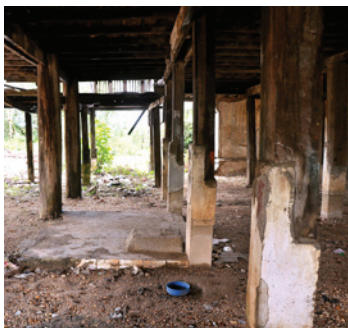
ภาพที่ 9 การเสื่อมสภาพของเสา (ภาพซ้าย) และผนังอิฐก่อของฐานชุกชี (ภาพขวา)
