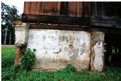
ภาพที่ 9 การเสื่อมสภาพของเสา (ภาพซ้าย) และผนังอิฐก่อของฐานชุกชี (ภาพขวา)
