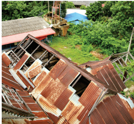
ภาพที่ 14 ความชำรุดทรุดโทรมของหลังคาสังกะสีที่ให้น้ำฝนรั่วเข้าไปได้ในอาคาร
