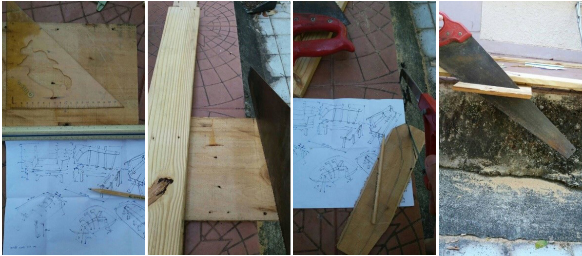
ภาพที่ 6 แสดงขั้นตอนการวัดและตัด เพื่อระยะใบเลื่อย (ความหนาของใบเลื่อย) ในการตัดกับแบบ (© Thapanut Kaewpan 2020)
