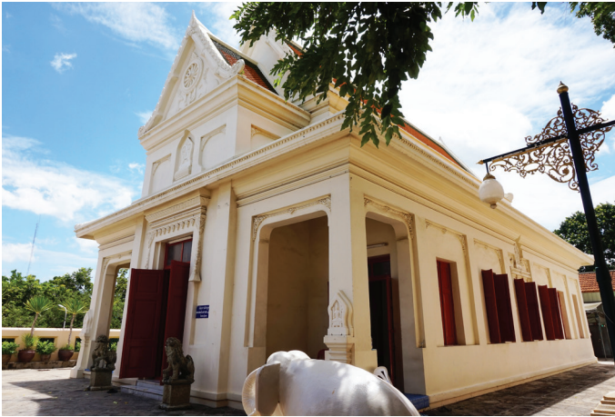
ภาพที่ 14 พระอุโบสถวัดพระปฐมเจดีย์ จังหวัดนครปฐม มุมมองด้านทิศตะวันตกเฉียงเหนือ
