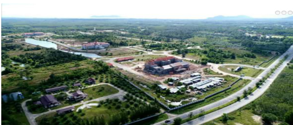
ภาพที่ 5 ทศนียภาพมุมสูงสถานที่ก่อสร้างอาคารฝึกปฏิบัติโรงแรมและ สถานที่ก่อสร้างอาคารเรียนรวม ที่มา: ประชาสัมพันธ์มหาวิทยาลัยราชภัฏสงขลา, 2561
