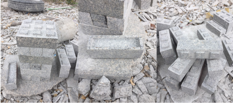
ภาพประกอบที่ 3 การทำลำต้นศาลพระภูมิด้วยวิธีการต่อแบบเรียงสลับ
