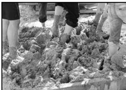
ภาพที่ 2 ขั้นตอนการเตรียมดินและก่อสร้างบ้านดิน
