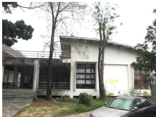
C อาคารต่อเติมใหม่ภายหลัง
