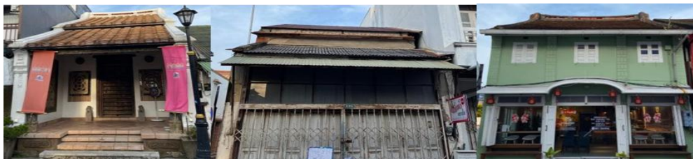
ภาพที่ 5 ห้องแถวแบบจีน (พาณิชย์) ถนนนครใน
