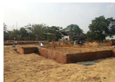
(จ) การถมดินในบ้านเพื่อเทพื้นแบบวางบนดิน
