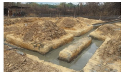
(ค) เทคอนกรีตเหล็กฐานราก
