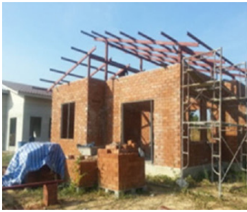
(ข) การติดตั้งโครงหลังคา จากผนังอิฐประสาน
