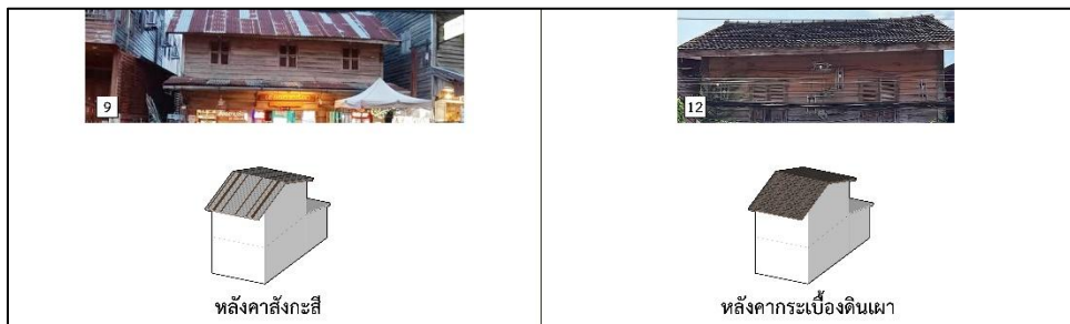
ภาพที่ 10 การเปลี่ยนวัสดุหลังคาของห้องแถวไม้
