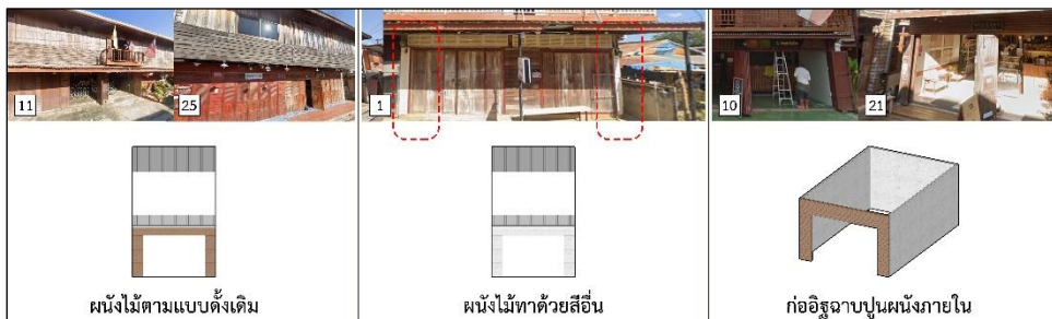
ภาพที่ 4 การปรับเปลี่ยนโครงสร้างและผนังส่วนพื้นที่ด้านหน้า ที่มา: ผู้วิจัย
