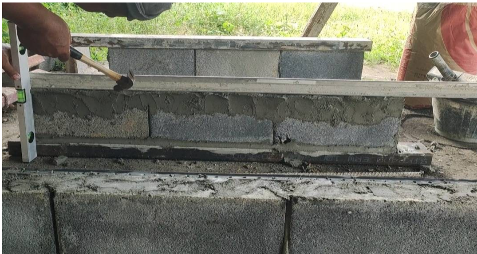
ภาพที่ 3 แสดงขั้นตอนการจับเซียมแบบดั้งเดิม
