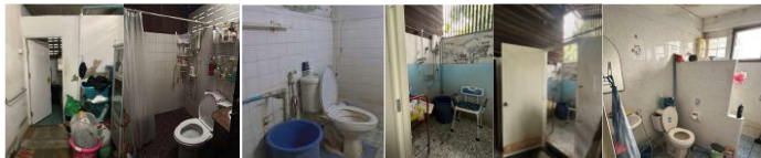
สภาพแวดล้อมของพื้นที่ห้องน้ำ
