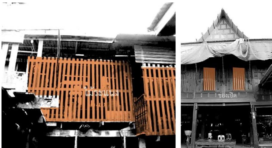
ภาพที่ 7 แสดงระแนงไม้บริเวณครัวและช่องเปิดของเรือนภาคกลาง ประเทศไทย ที่มา: ดัดแปลงจาก เกรียงไกร เกิดศิริ (2018)
