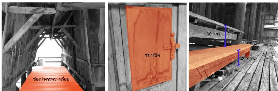
ภาพที่ 3 แสดงช่องทางระหว่างเรือน (ฮ่อมริน), ช่องเปิด และระดับพื้นของเรือนกาแลพญาวงศ์ ที่มา: ดัดแปลงจาก ชูติมณฑน์ ศิริติกุล (2017, หน้า 59-70)
