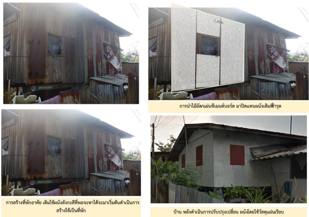
ภาพที่ 7 การปรับปรุง/ซ่อมแซม ที่อยู่อาศัยของผู้มีรายได้น้อย
