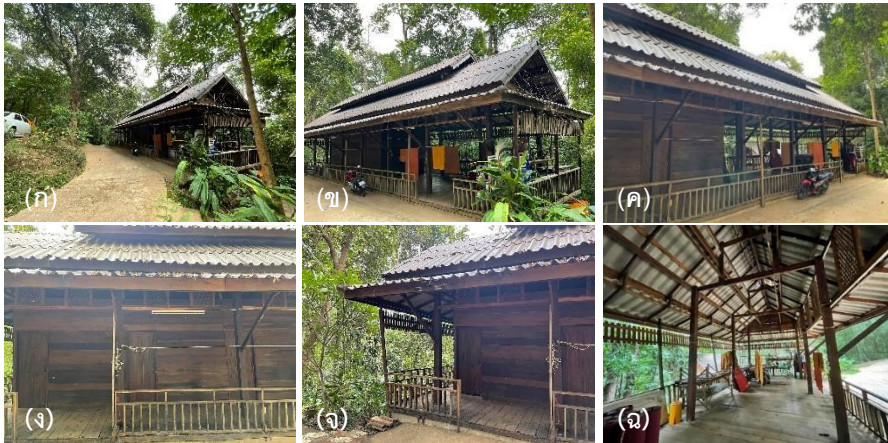
ภาพที่ 4 (ก) สภาพแวดล้อมโดยรอบ (ข) รูปแบบอาคารศาลารวมใจ (ค) อาคารไม้ 1 ชั้น (ง) ด้านข้างอาคาร (จ) หลังคาทรงจั่วปั้นหยา 2 ชั้น (ฉ) ภายในศาลารวมใจ
